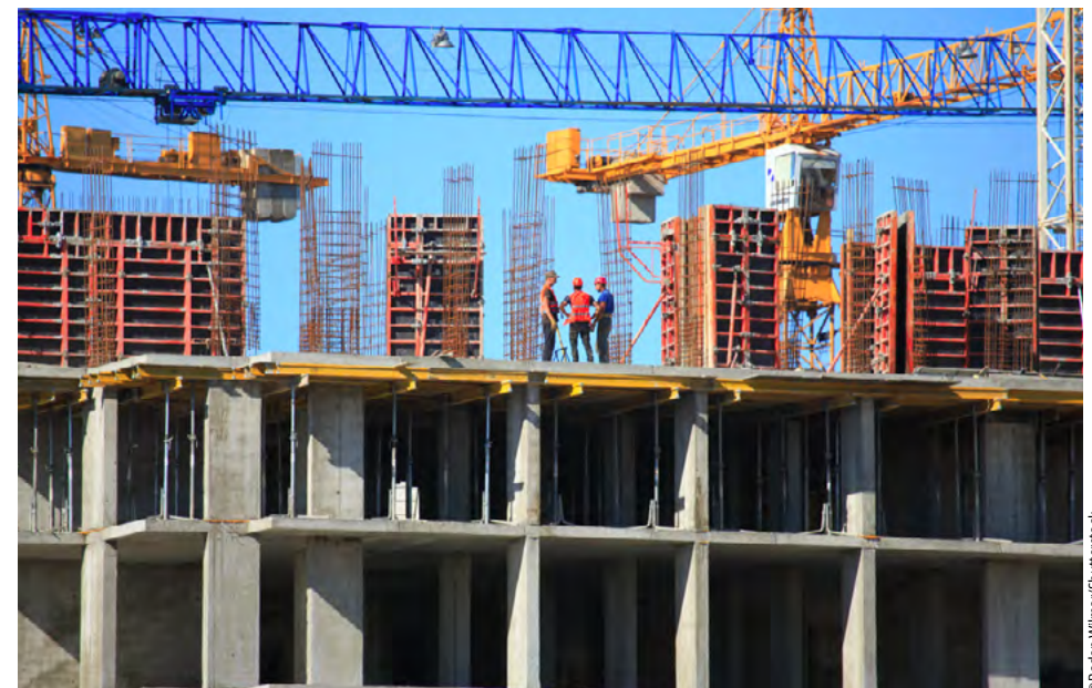
Obwohl sich die Ukraine noch im Krieg befindet, wird bereits vieles wieder- oder neu aufgebaut.
